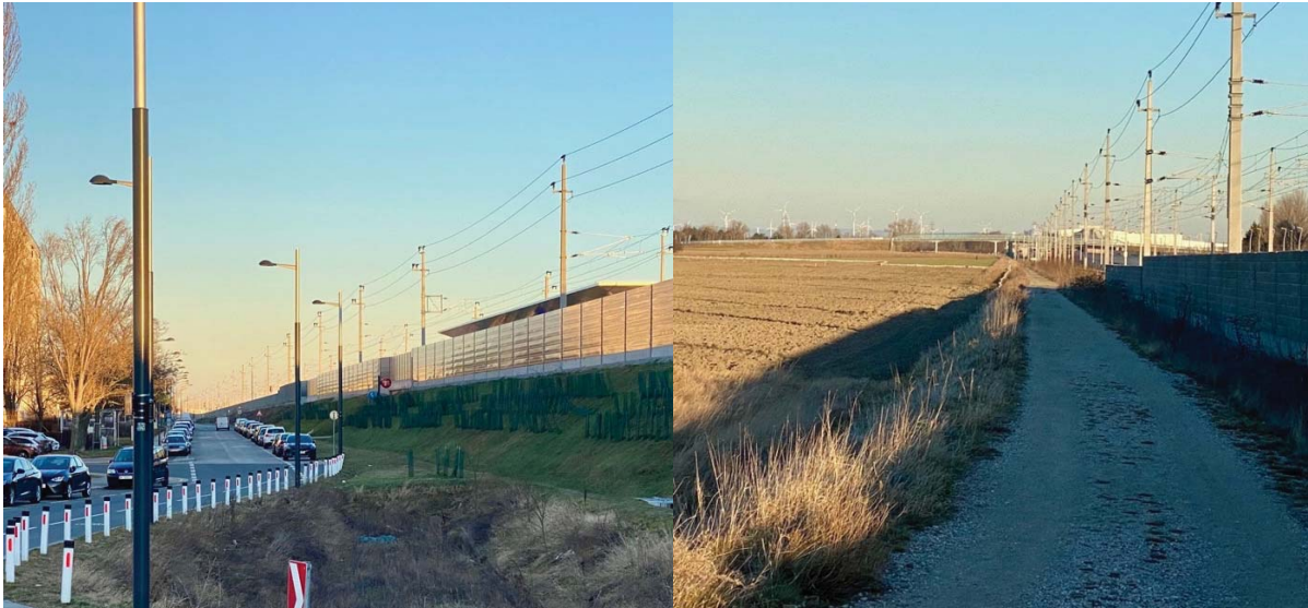
Blicke Richtung Osten: Die S-Bahn-Station Hirschstetten rechts, von der Hausfeldstraße Blick zur Station Aspern Nord im Hintergrund (Fotos Norbert Mayr).
